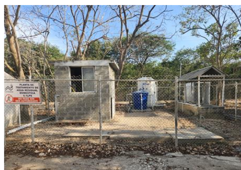
Ilustración 85. Planta de tratamiento de aguas residuales capacidad 0,12 LPS
