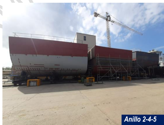
Ilustración 23. Avance proceso construcción Patrullera Oceánica Colombiana (POC)
