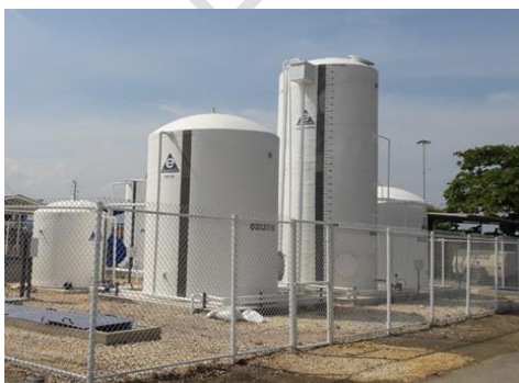
Ilustración 84. Planta de tratamiento de aguas residuales capacidad 1,12 LPS
